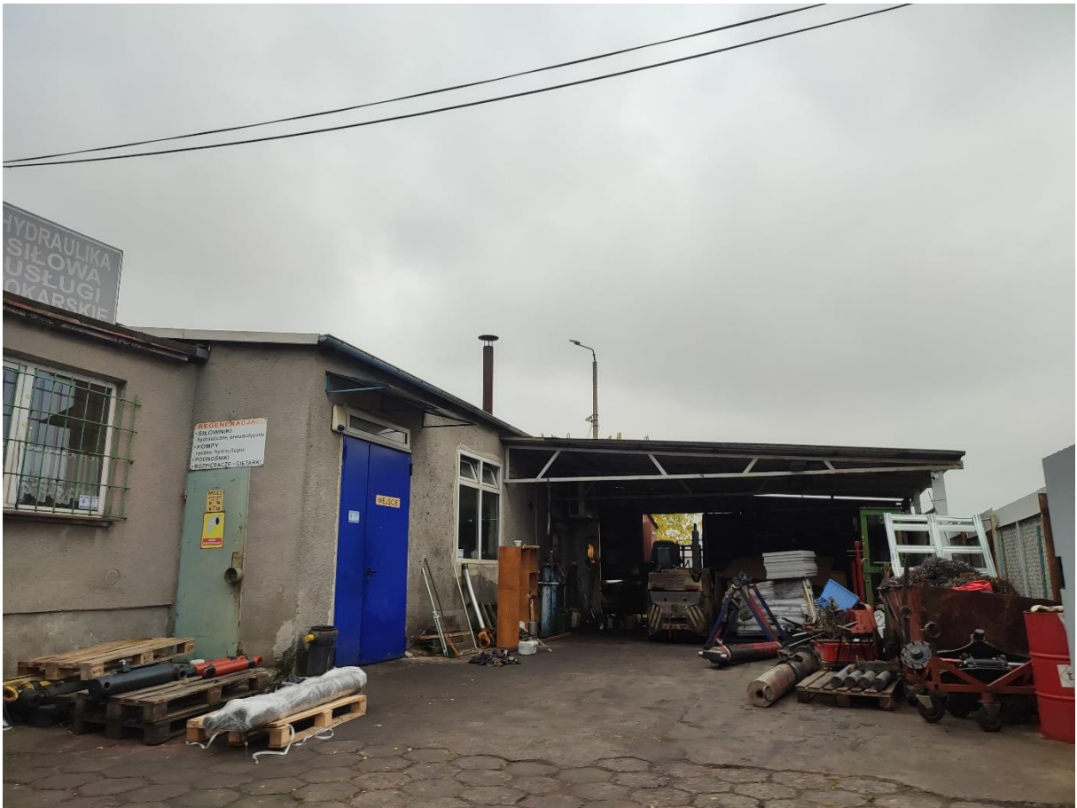
Fotografia 5. Widok na tereny w północnej części obszaru
