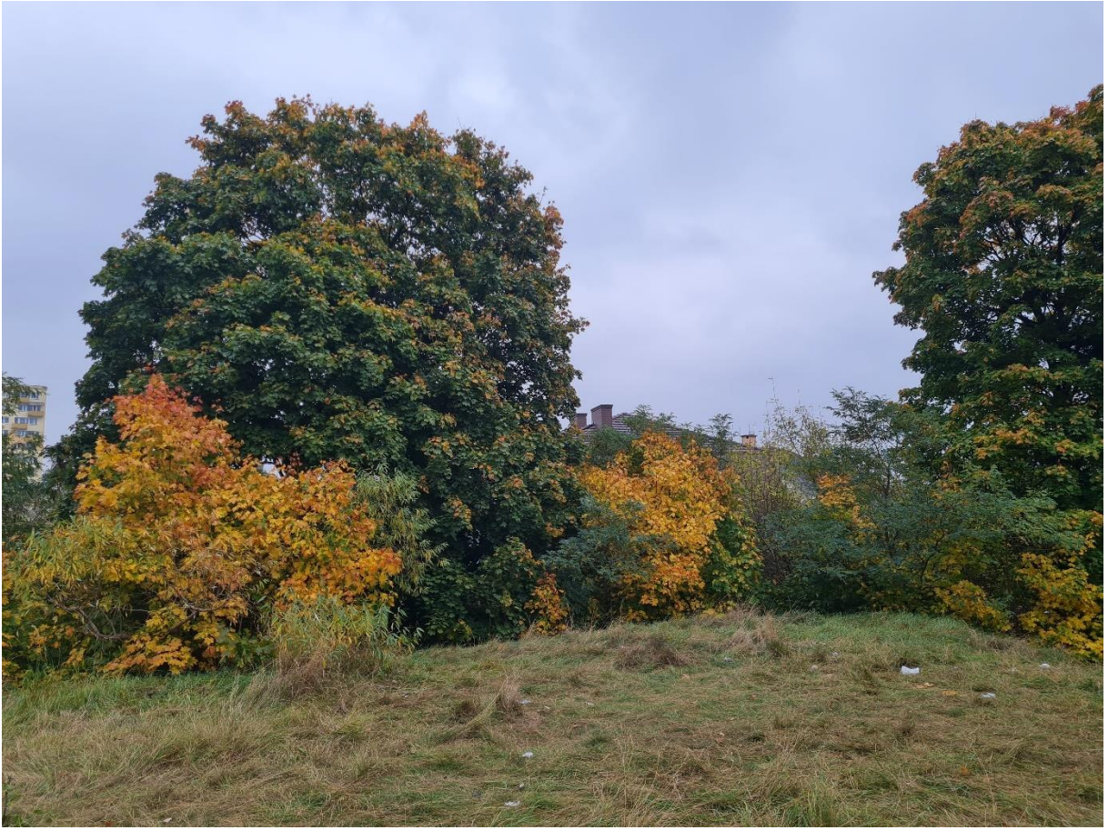
Fotografia 1. Czasza zabytkowego schronu piechoty J-4, widoczne odpady w rozproszeniu powodujące degradację krajobrazu
