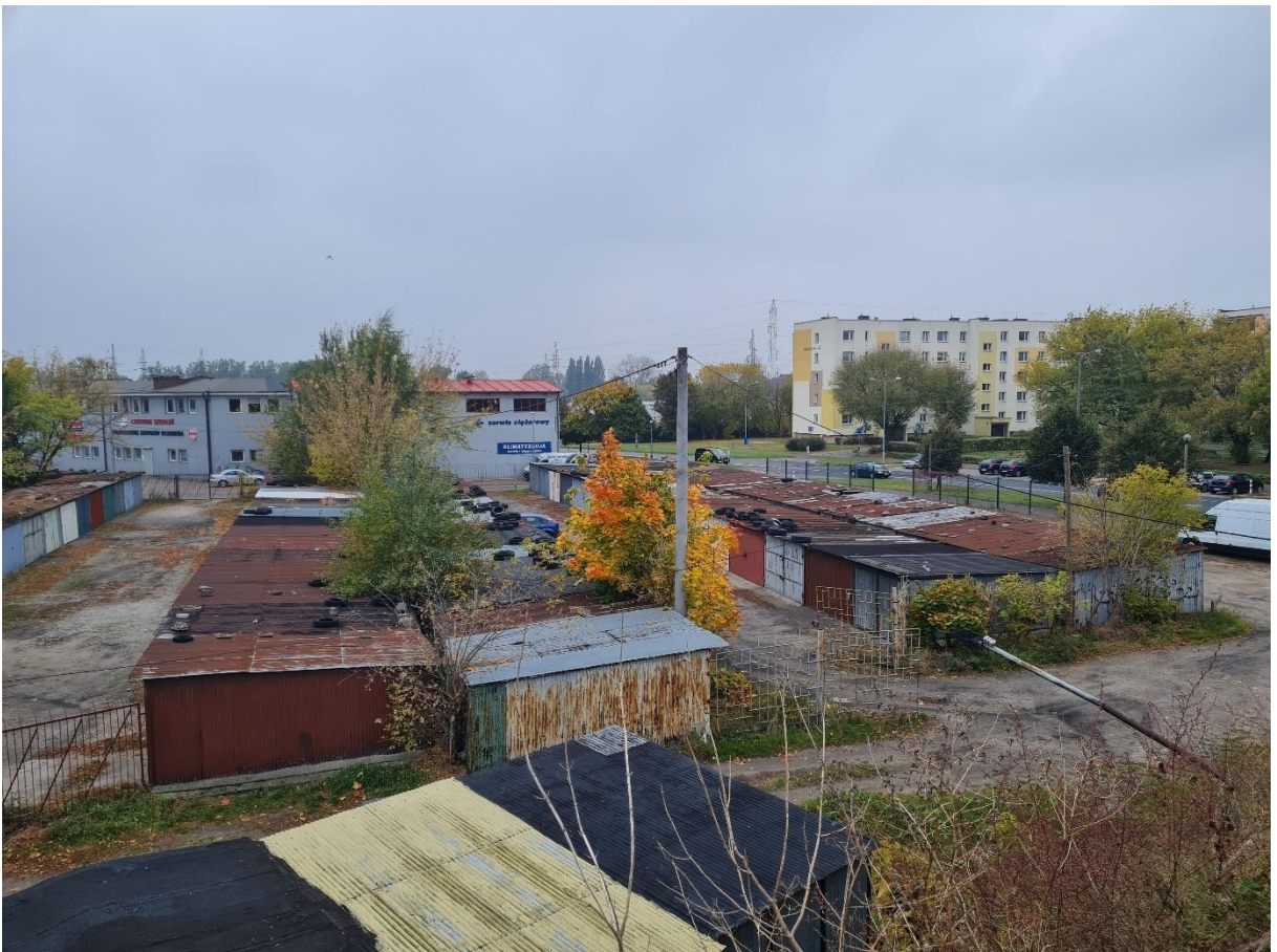
Fotografia 2. Widok na tymczasowe, blaszane garaże w rejonie schronu
