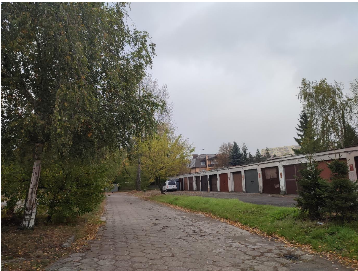
Fotografia 3. Widok na murowane garaże zlokalizowane wzdłuż ul. Czeresniowej
