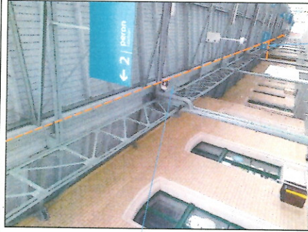
proj. kable UTP na istn. trasach kablowych
