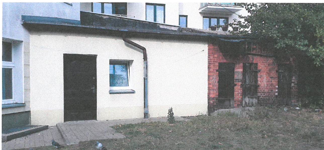
Zdj.11 Fragment budynku mieszkalnego na dz. nr 18 przyległego do rozpatrywanego budynku gospodarczego.
