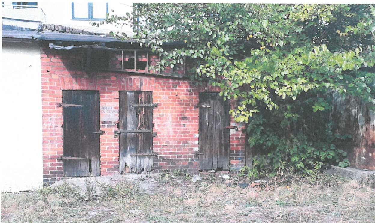
Zdj.1 Elewacja frontowa południowo-wschodnia
