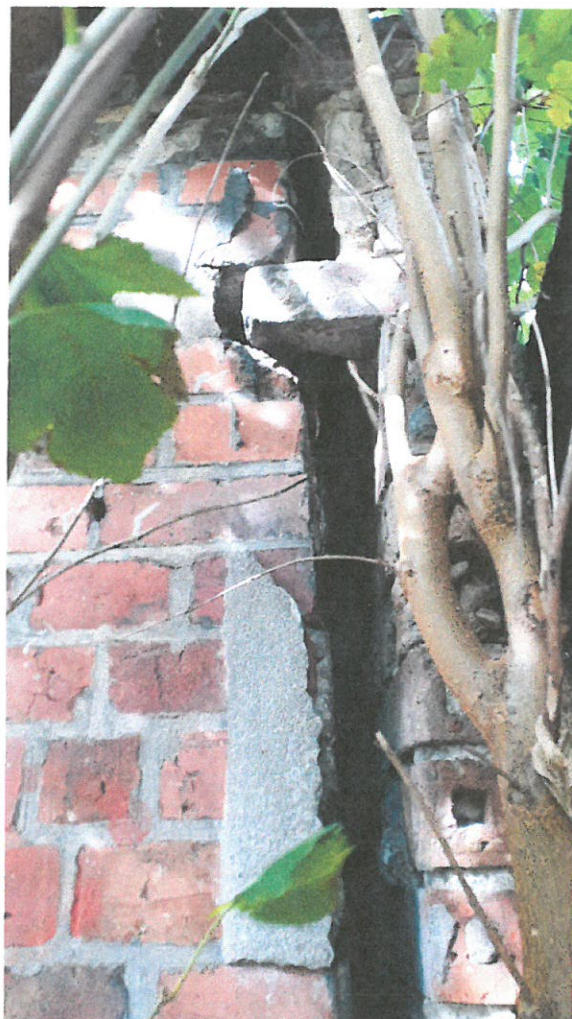
Zdj.9 i 10 Pęknięcie narożnika ściany od strony wschodniej
