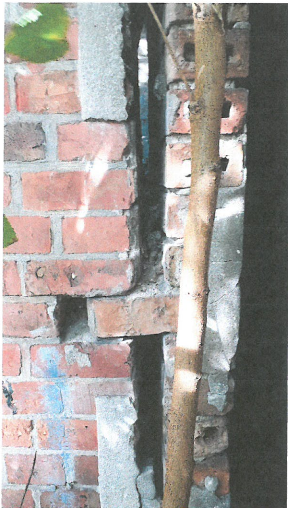
Zdj.9 i 10 Pęknięcie narożnika ściany od strony wschodniej
