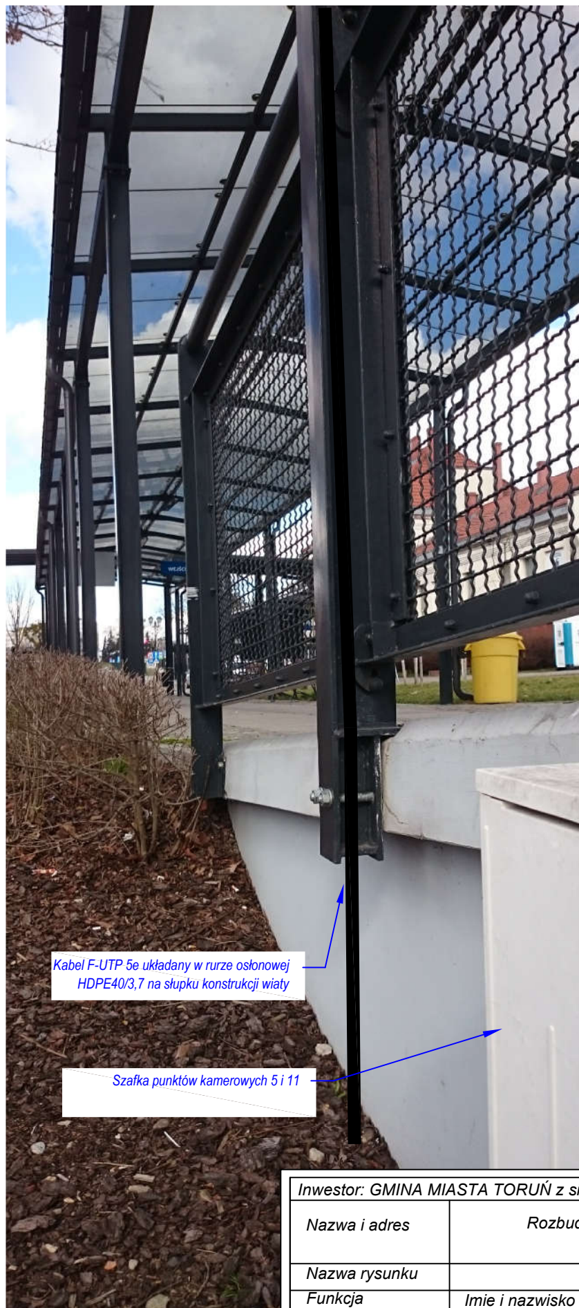
Kabel F-UTP 5e układany w rurze osłonowej HDPE40/3,7 na słupku konstrukcji wiaty
