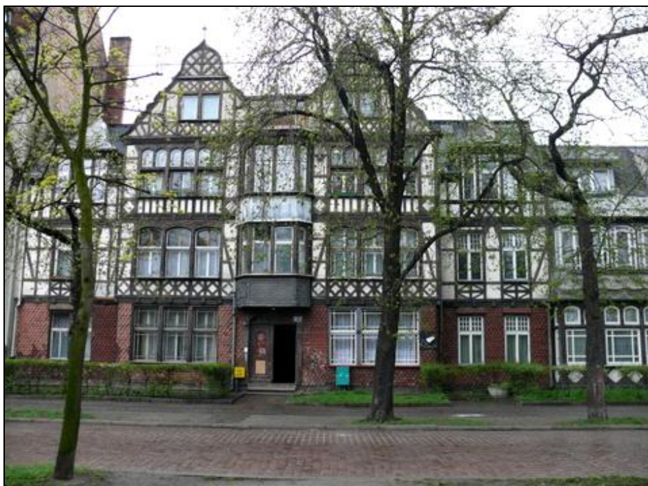
Fotografia 2. Kamienice przy ul. Bydgoskiej 50–52, widok od frontu, od ul. Bydgoskiej Źródło: http://bydgoskie.blox.pl/2008/04/Rejestr-zabytkow-nieruchomych.html
